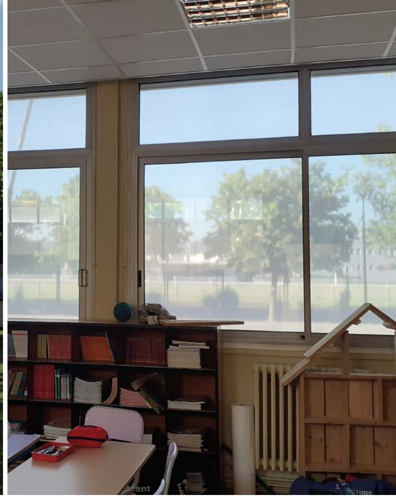
École équipée de protections solaires (stores screen vertical extérieur) permettant de diminuer la température intérieure de 10 °C par rapport à l'extérieur. École maternelle Michel de Montaigne - Groupe scolaire Les Sablons © Ville de Poissy.
