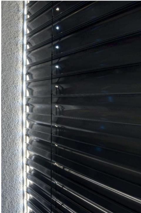
**Figure 2 : Diffusion de lumière admissible à travers la coulisse**
